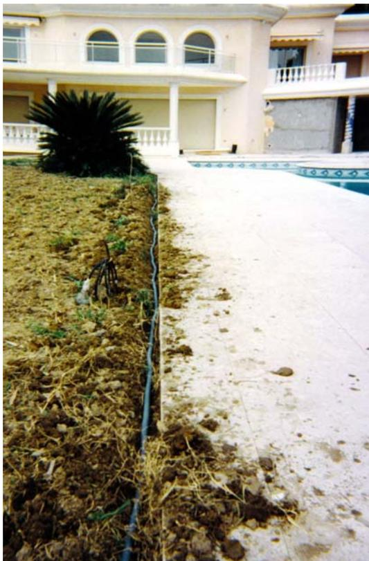
Pour conduire votre câble multi paires vers les bornes infrarouges vous devez utiliser un tube de protection en PVC ( Diamètre 20mm ) dans lequel passera votre câble. Il est cependant recommandé d'utiliser une gaine électrique ICTA
